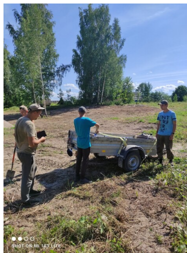
Благоустройство тропы на территории будущего сада: укрепление края тропы досками и резиновой лентой, засыпка гравием, утрамбовка. Работы выполнены сотрудниками партнера проекта АО "Шексна" (июль 2024 г.)
