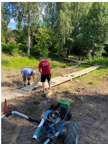
Обустройство дорожки (июль 2024 г.)
