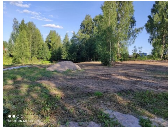
Рекультивация и выравнивание земельного участка (июль 2024 г.).
