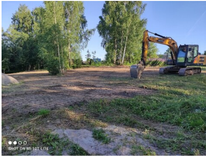
Рекультивация и выравнивание земельного участка (июль 2024 г.).
